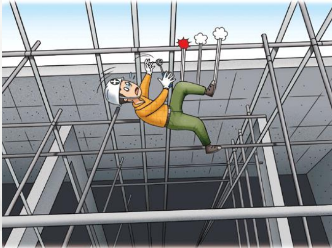
(강관 파이프 설치중 실족)
