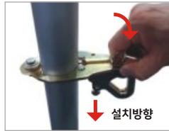
Step2. 양쪽을 맞물리게 오므린 후 안전 레버로 체결 완료.
